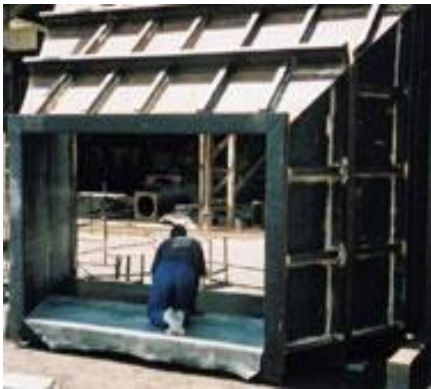
نمونه مخزن در حال لاینینگ
